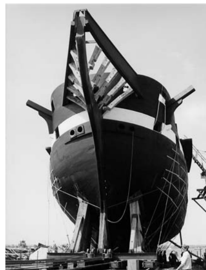
Pormenor do restauro estrutural
